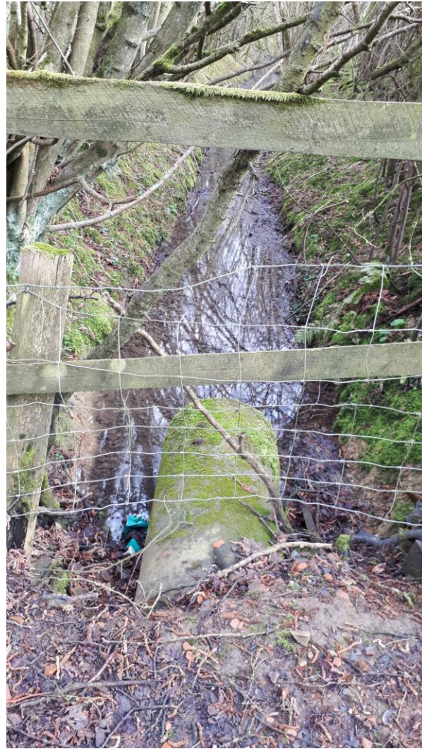
G171 _ DS of culvert looking SE
